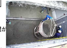
基礎・埋戻工 施工状況
