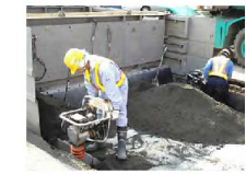
埋戻転圧状況
